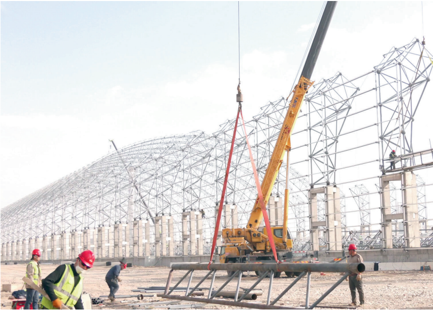
在拜城县泓泰500万吨智能储备项目建设现场，工人正在焊接管材、安装储煤仓框架。
